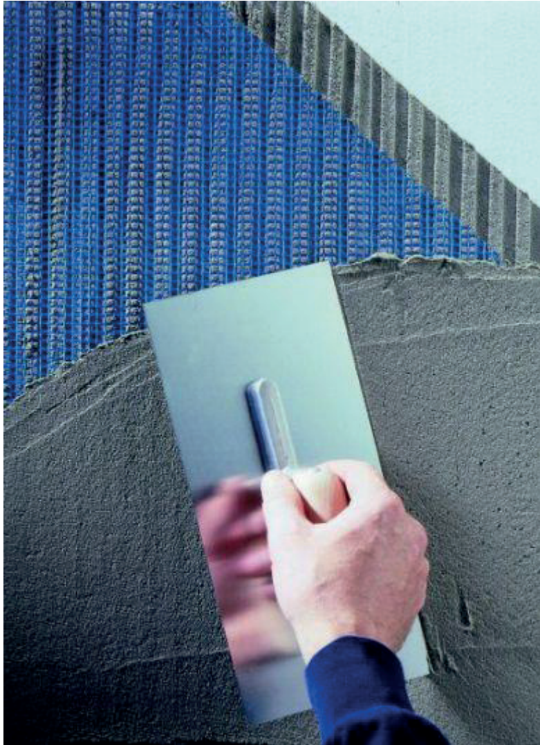
8. ábra: Vakolaterősítő háló ágyazása
