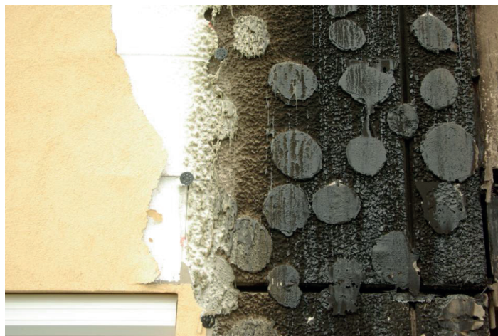
3. ábra: Homlokzati tűzesetben károsodott hőszigetelő rendszer, melynek kivitelezése során nem a pont-perem módszert alkalmazták.
