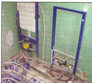
A gépészeti vezetékek elhelyezése
