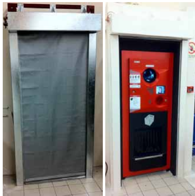
FÜGGÖNYKAPU, MINT KIZÁRÓLAGOS MEGOLDÁSI LEHETŐSÉG (A SZŰK NYÍLÁSBA BEÉPÍTETT, RENDSZERES HOZZÁFÉRÉST IGÉNYLŐ ÜVEGVISSZAVÁLTÓ GÉP MÖGÖTT)
