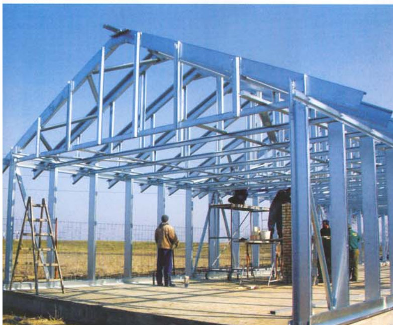
Helyszínen szerelt fémvázaz épület
