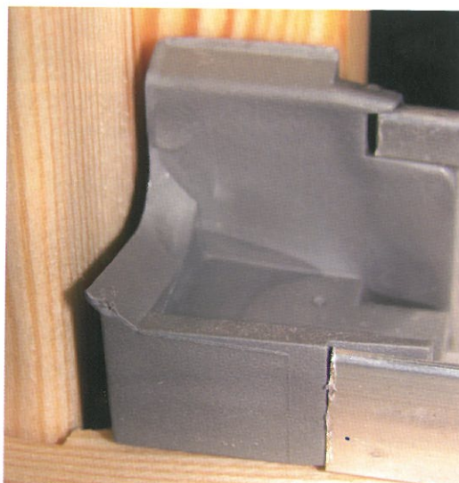
2. kép: A korszerű vízelvezető rendszer alkatrészei pontatlan összeépítés esetén beengedik az esővizet
