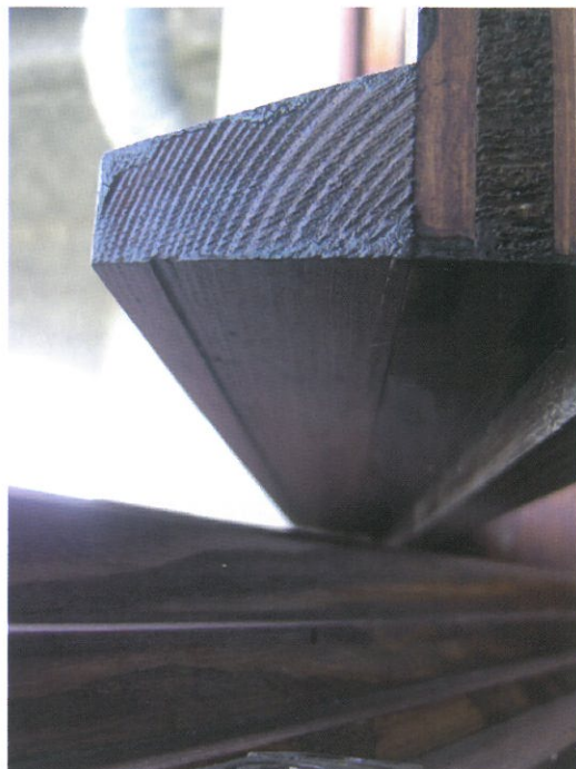
3. kép: Vízcseppárok, csiszolás és lazúrmennyiség éppen csak megmutatva
