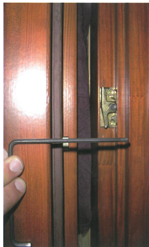
4. kép: A legjobb beállítás mellett sem működik a vasalat, ha rossz helyre csavarozzák a rögzítőelemet.
